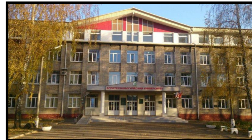
2 учебный корпус, ул. Вишнёвая д.33
