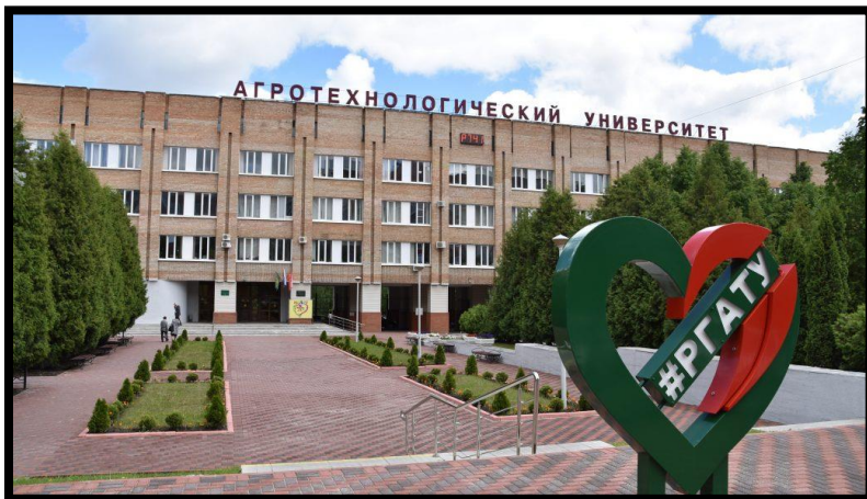
Главный корпус, ул. Костычева д.1
